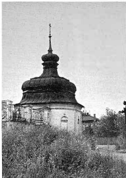
Угловая башня ограды Фот. 1970 г.
