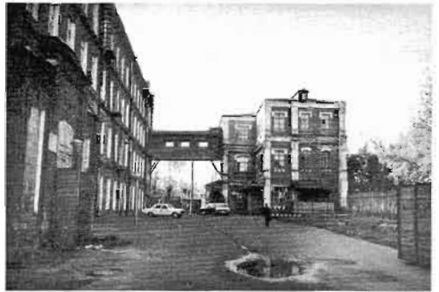
Заводоуправление. Фот. 1995 г.
