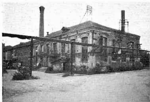
Фабрика С.И. Посылина. Котельная. Фот. 1995 г.
