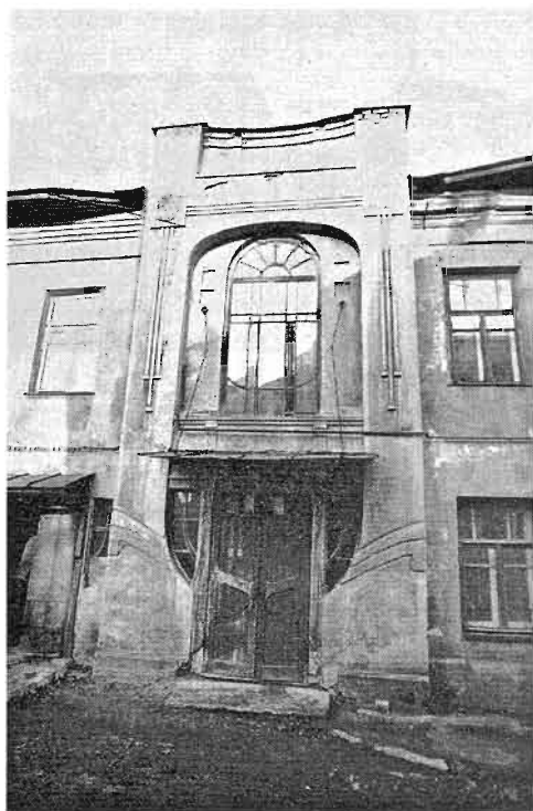
Главный вход. Фот. 1988 г.
