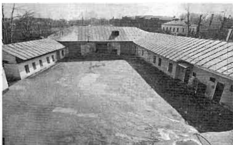
Усадьба Поповых. Флигель с конюшней, каретный сарай и служебная постройка. Фот. 1988 г.
