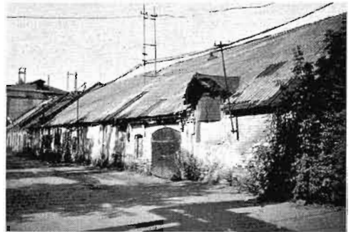
Фабрика М.А. Павлова. Склады 1882 г. Фот. 1995 г.
