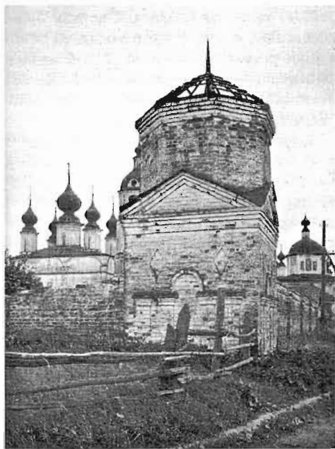
Угловая баня ограды. Фот. 1975 г.
