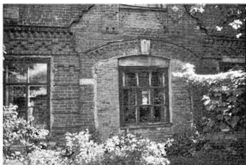
Усадьба Небурчиловых. Конюшня. Фрагмент фасада. Фот. 1988 г.
