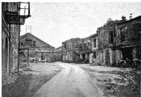
Фабрика М.А. Павлова. Отделочный корпус и турбинное отделение. Фот. 1995 г.
