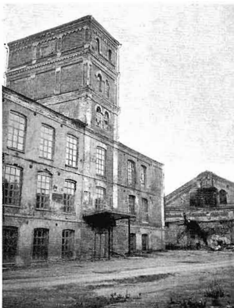
Фабрика М.А. Павлова. Башня прядильно-ткацкого корпуса. Фот. 1995 г.
