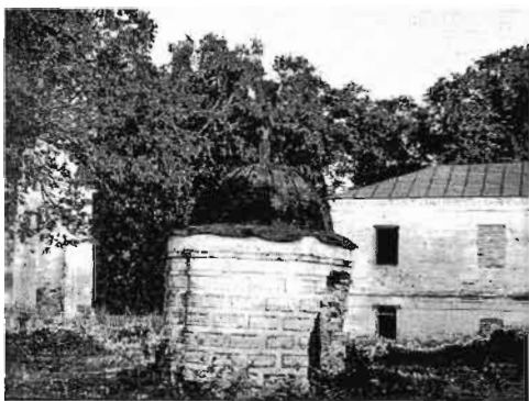
Башня ограды. Фот. 1970 г.
